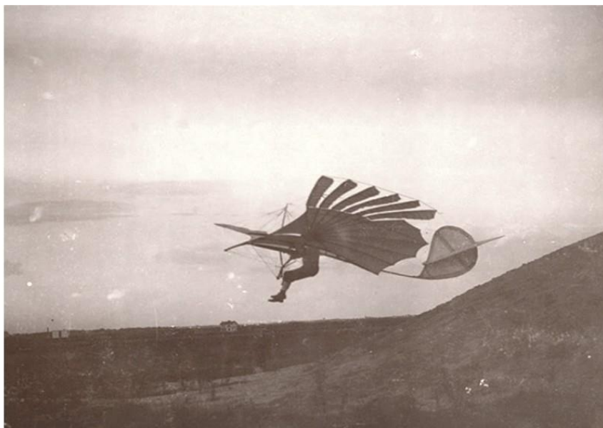
Aparat z trzepoczącymi skrzydłami w mniejszej wersji, do której Lilienthal nie przewidywał montażu silnika
